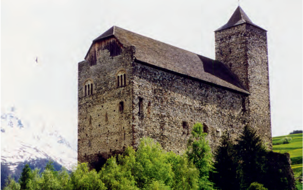
■ Abb. 4: Ansicht der Burg im Jahr 1994. Sicht auf die Ost- und Nordfassade. Die damals noch kleinen Bäume nahe der Fassade wurden später teilweise gefällt, da sie die Benutzbarkeit der Brutnischen für die Dohlen behinderten. Außerdem schädigt das Wurzelwerk die Mauerfundamente. Bild: W. Bürkli.
